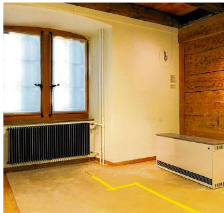
Das alte (r.) und das neue Heizsystem im Museum. Bild Corinne Aeberhard
